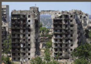
Разрушенные жилые дома в Мариуполе. Июнь 2022 г. Фото РИА Новости
