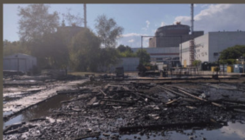
Последствия атаки украинских БПЛА на Запорожскую АЭС. г. Энергодар. Июль 2022 г.
