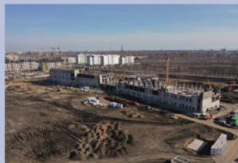
Строительство комплекса ФМБА в Мариуполе. Больница возведена за 84 дня!
