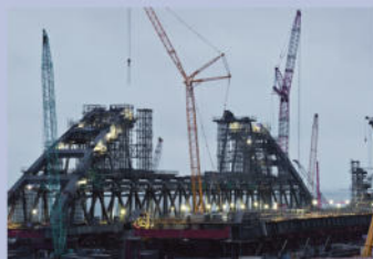
Строительство моста через Керченский пролив в Крыму. Сборка арочных пролетов для фарватерных опор моста. Фото РИА Новости
