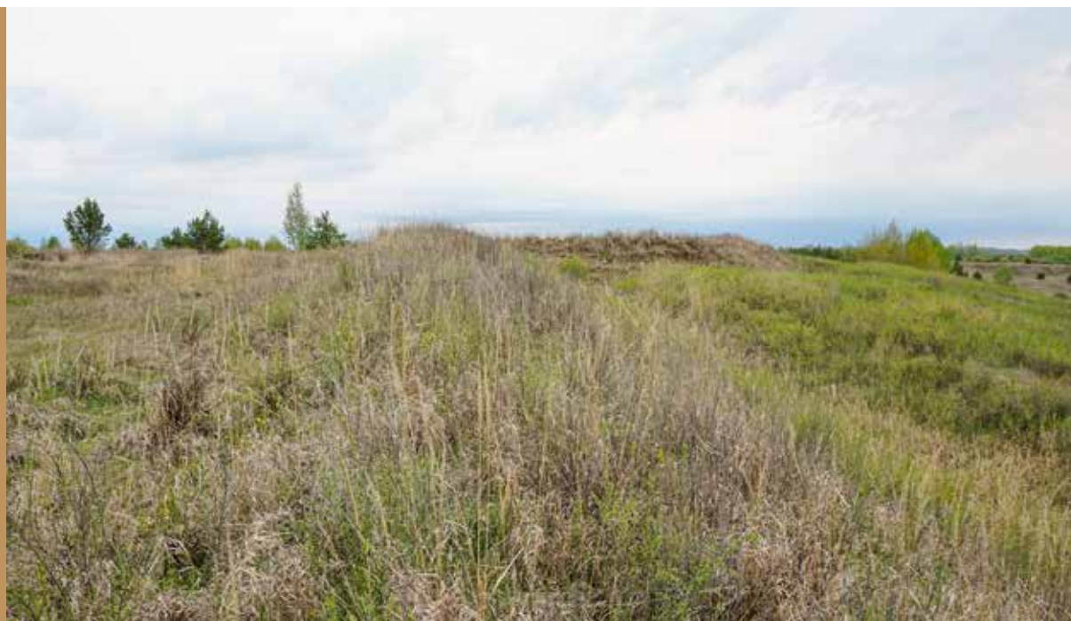
Шацкие сооружения. Видовое фото
