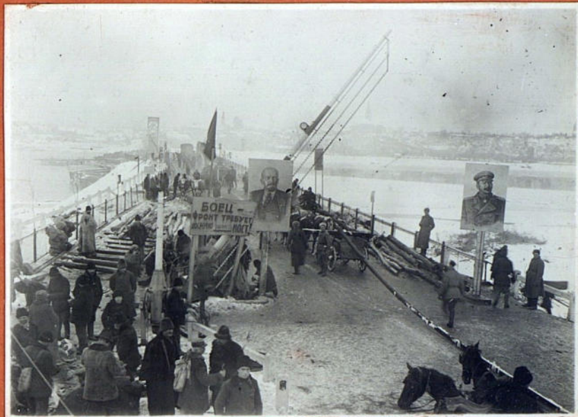
ВЪЕЗД НА МОСТ С ЛЕВОГО БЕРЕГА
