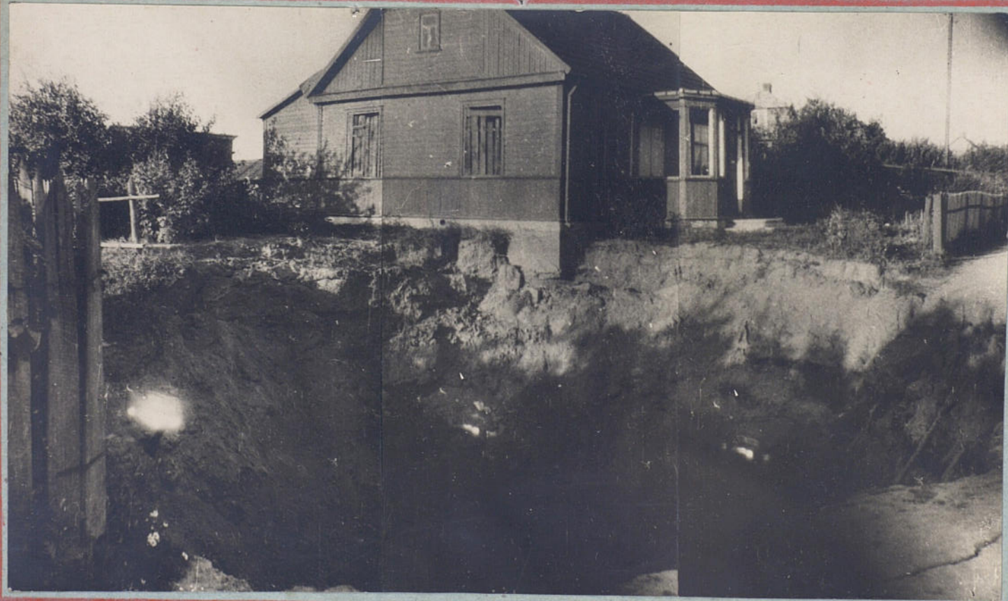
ВОРОНКА НАД РАЗРУШЕННЫМ ЖЕЛ.-ДОР. ТОННЕЛЕМ
