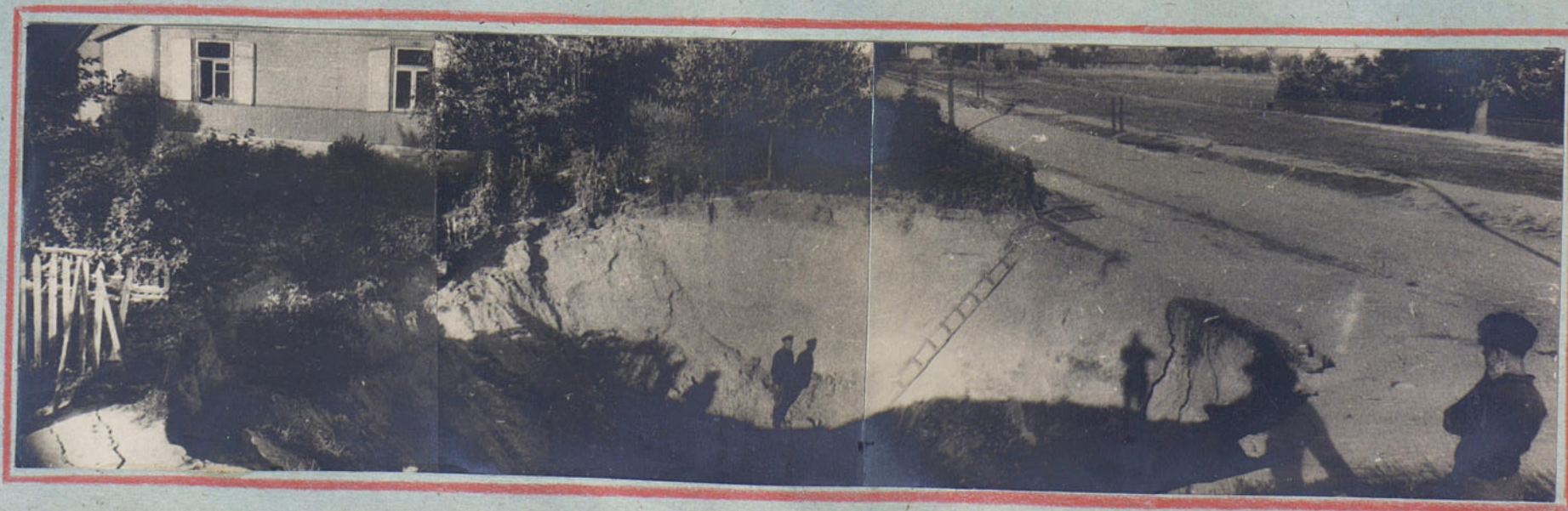
ВОРОНКА НАД ТОННЕЛЕМ
