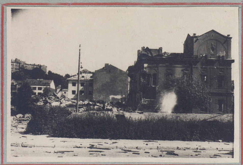
Взорванная электростанция (общий вид)
