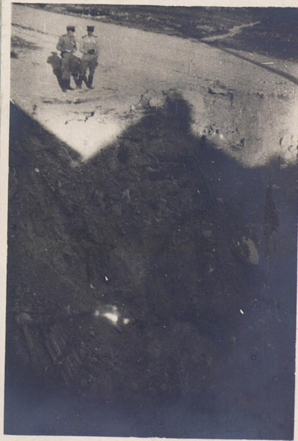
ВОРОНКА НАД РАЗРУШЕННЫМ Ж.Д. ТОННЕЛЕМ
