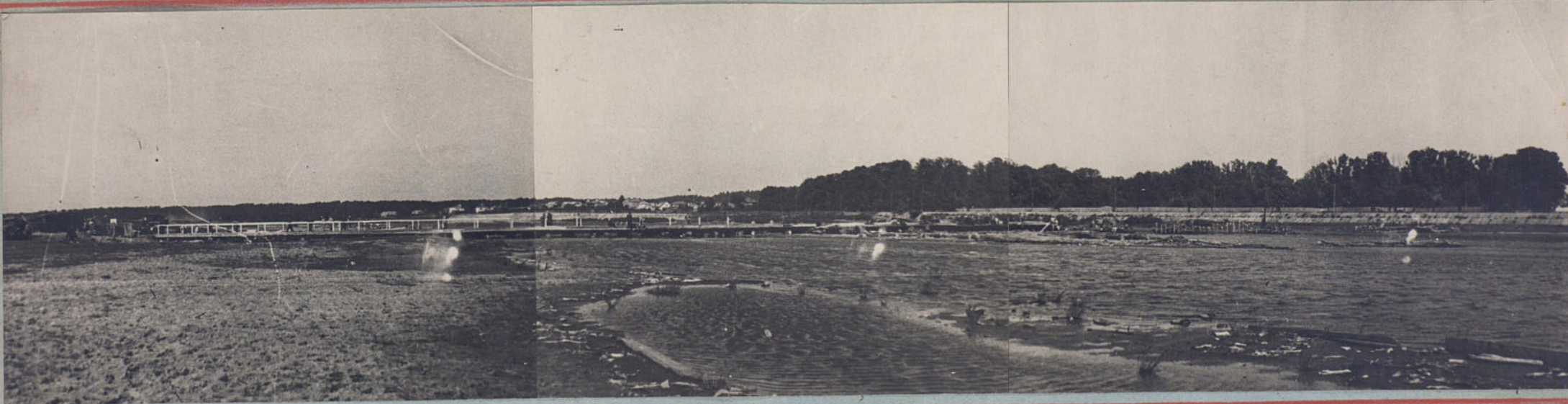
Мост через р. Неман грузоподъемн. 70 т., построенный 19-ОПМБ (в стадии строительства)
