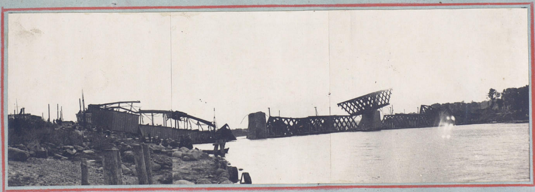
Разрушенный ж.-д. мост через р. Неман
