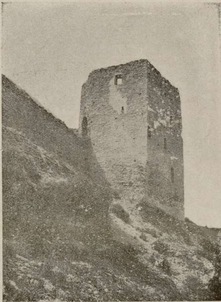
Рис. 2. ИЗБОРСКЪ. ПЛОСКАЯ БАШНЯ. ВИДЪ СЪ СЪВЕРО-ВОСТОЧНОЙ СТОРОНЫ.
